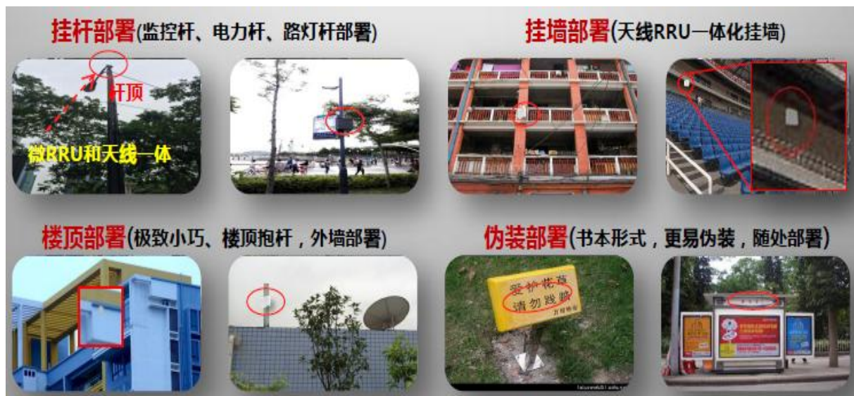
图 3-8 微基站景观化建设示例
