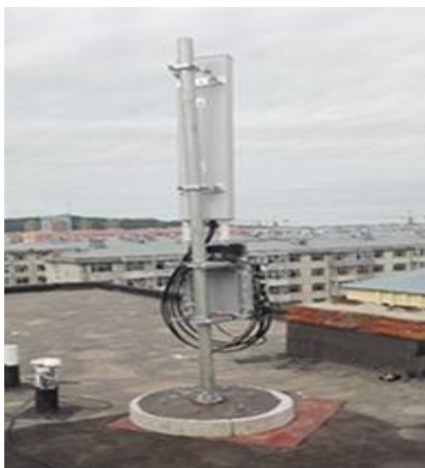
图 3-1 楼面抱杆应用场景
