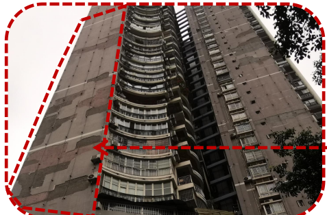
建筑外立面瓷砖脱落严重, 影响公共安全
